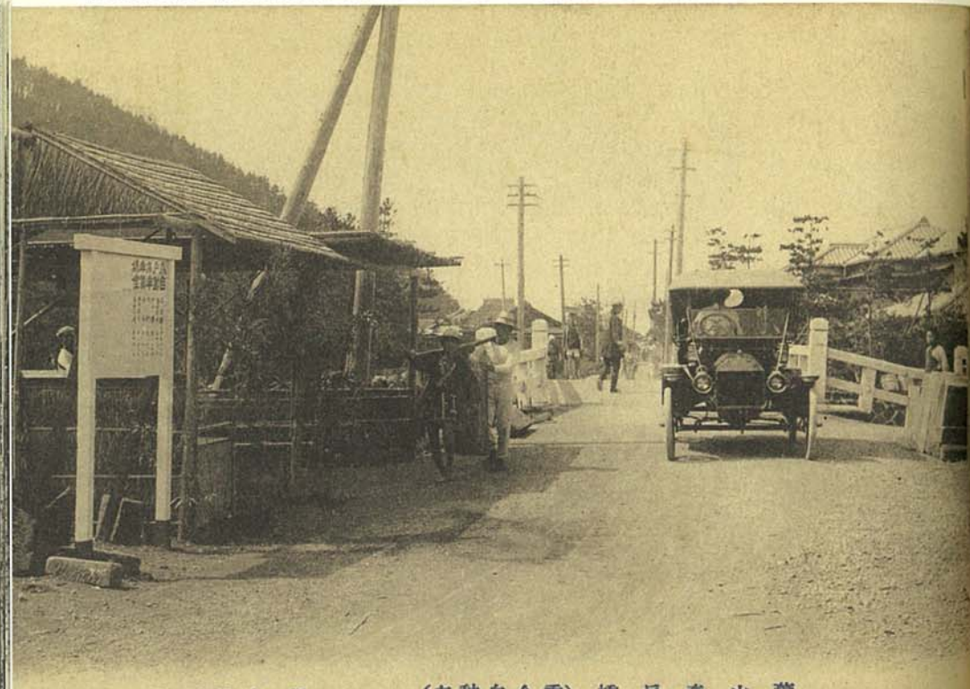
Morido Bridge, Hayama. (車動自合乗) 橋戸森山葉
